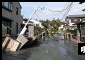
支持力が低下し、建物や塀等に沈下・傾きが生じる
